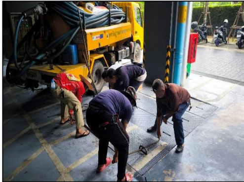
ภาพที่ 62 กิจกรรมสูบน้ำจากตะกอนและดูดกากไขมัน
