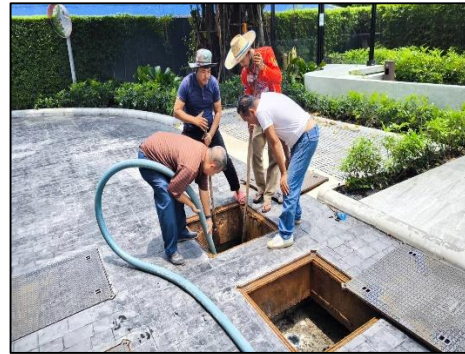
ภาพที่ 62 กิจกรรมสูบน้ำจากตะกอนและดูดกากไขมัน
